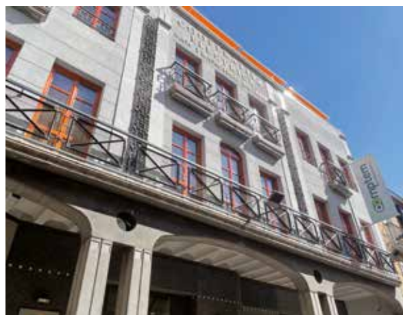
Figura 5.- Fachada de la Cooperativa Eléctrica San Francisco de Asís en Crevillent.
