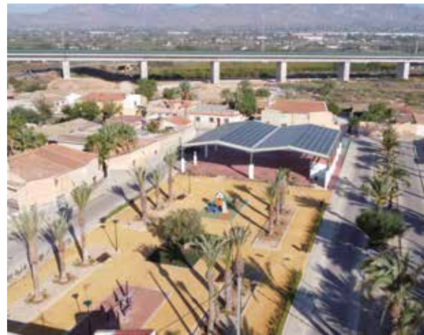
Figura 8.- Instalación de autoconsumo colectivo COMPTEM en El Realengo.
