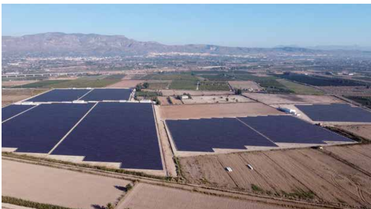
Figura 7.- Planta solar fotovoltaica El Realengo.
